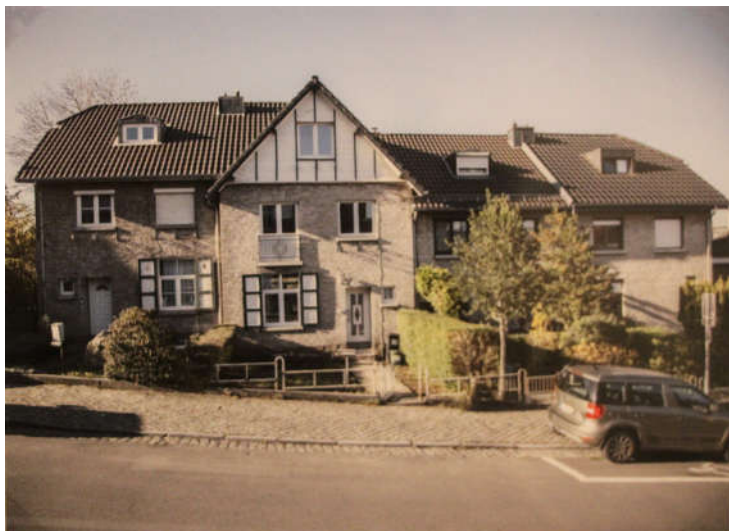
Maisons d'employés pour la firme Peltzer et fils, rue des Côteaux à Verviers, 1924-1925.
